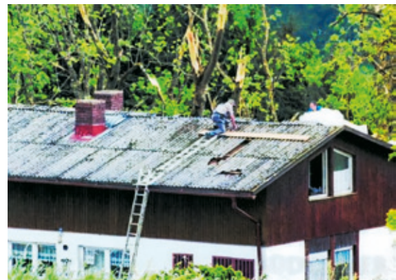
Reparaturarbeiten am Dach
